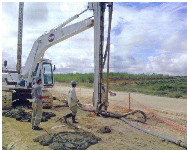
Figura 3: Técnica de geoenrijecimento
