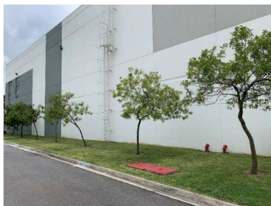
Figura 3: Hidrante de Recalque
