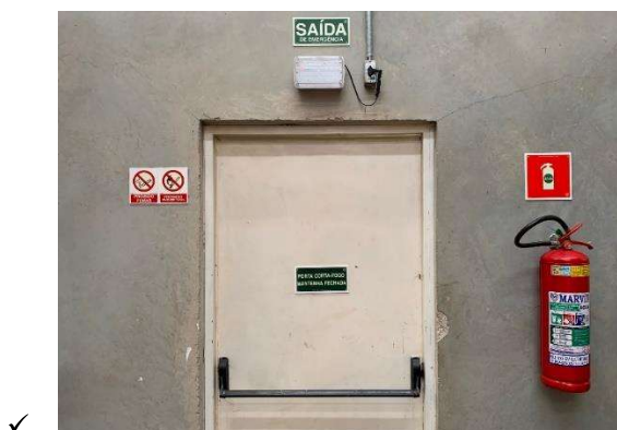
✓ Figura 10: Saída de Emergência
