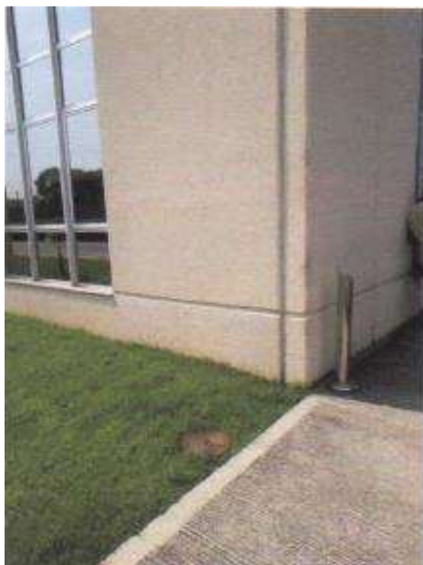
Figura 11: Caixa de inspeção
