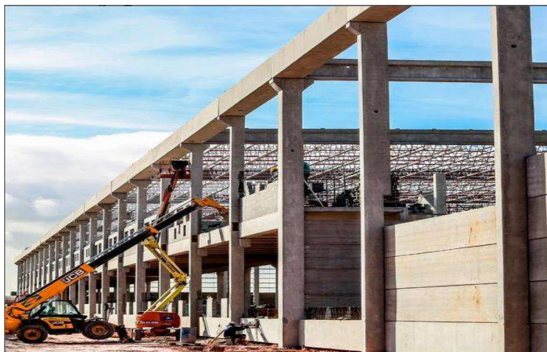
Figura 7 Processo de construção; Pré moldado. Fonte: TELMEC Engenharia (2021)
