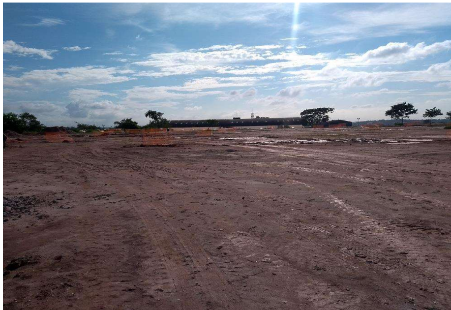
Figura 6 Terreno nu Fonte: TELMEC Engenharia (2021)
