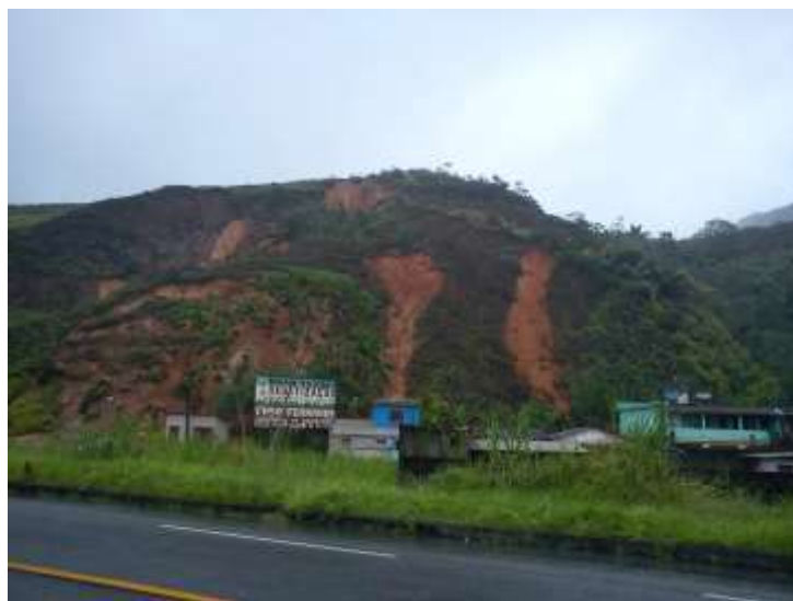
Figura 2 Construções na área de estudo - Fonte: Arquivo da Defesa Civil de Angra dos Reis
