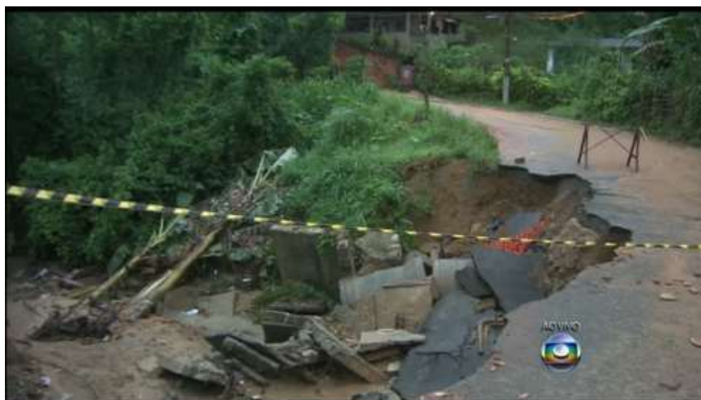
Figura 1: Destroços de casa engolida por deslizamento de encosta na cidade de Nova Iguaçu. Fonte: G1 (2018), (12/12/2013).
