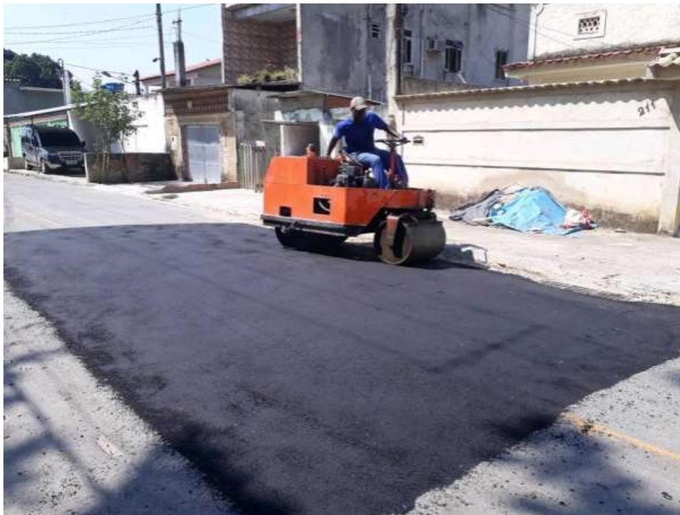
Figura 13: operador do rolo compactador Fonte: (Autor, 2018)
