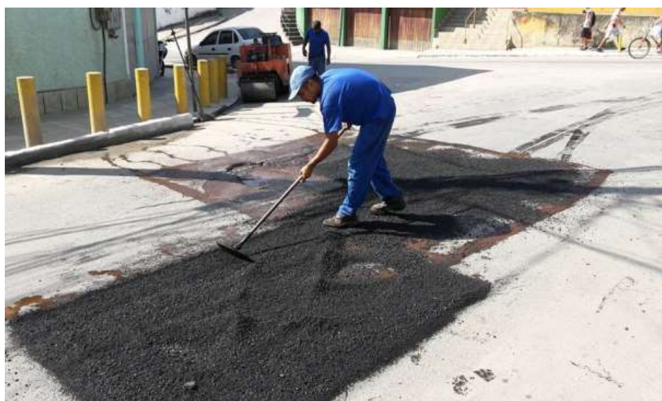
Figura 12: aplicação e nivelamento da massa asfáltica Fonte: (Autor, 2018)
