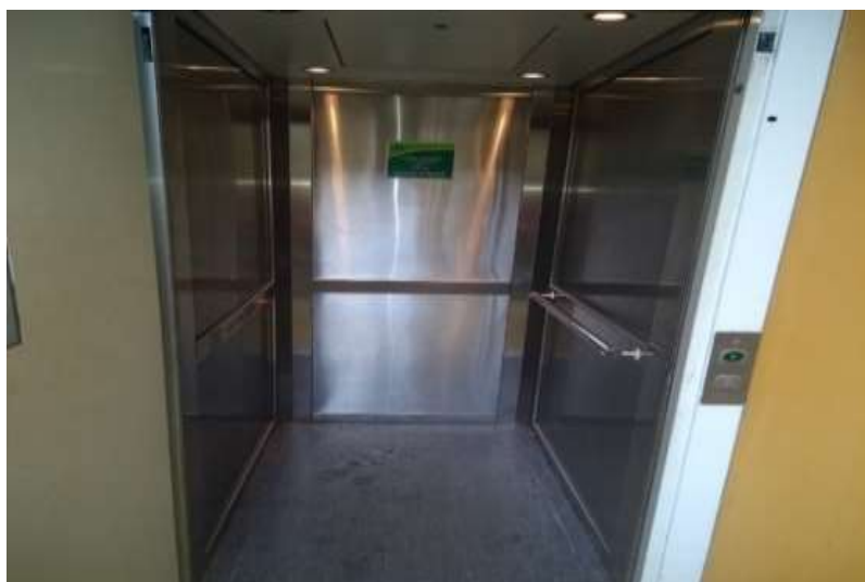
Figura 8 Interior do elevador de acessibilidade Fonte: Autora (2018)
