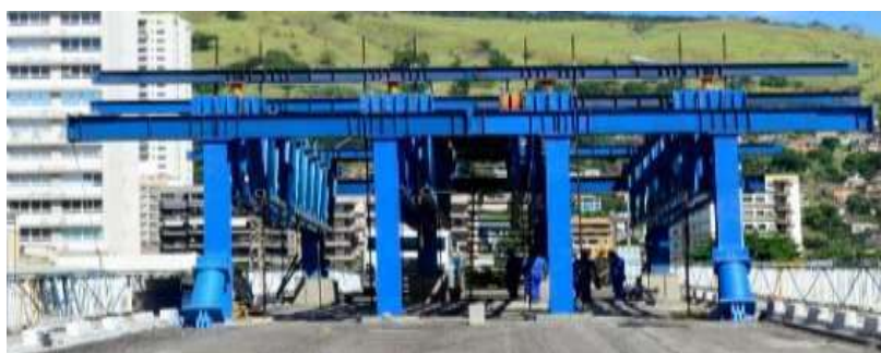
Figura 6: Macacos Hidráulicos Para Procedimento de içamento
