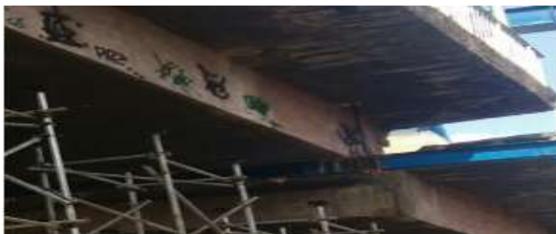
Figura 5: Içamento do vão para reparo do dente gerber
