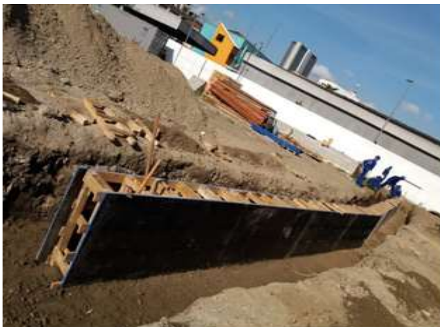
Figura 1- Confecção da mureta guia
