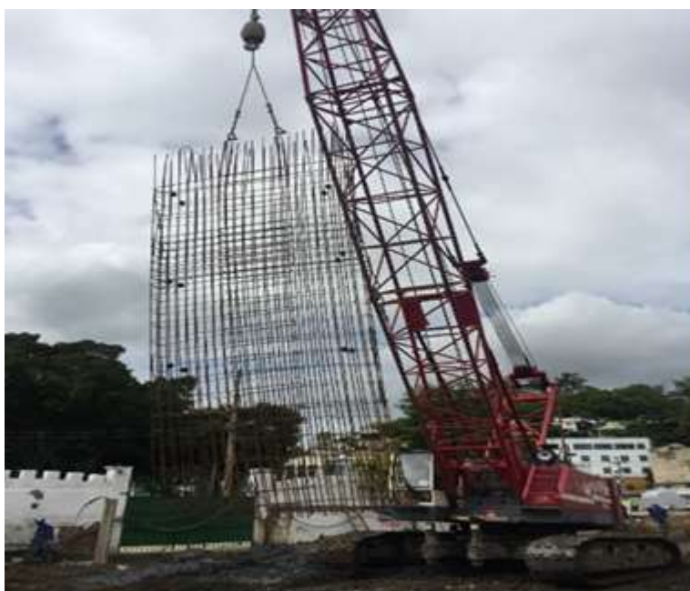
Figura 02 - Posicionamento da Armadura
