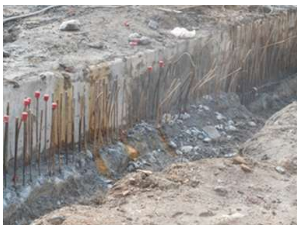
Figura 04 - Arrasamento da viga de coroamento
