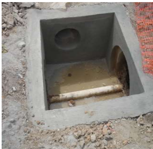
FIGURA 13: Caixa de passagem finalizada
