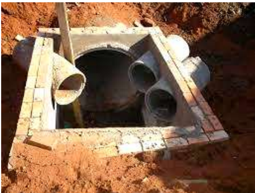
FIGURA 4: Modelo de caixa de ligação.
