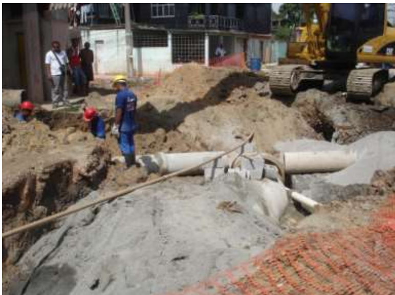
FIGURA 10: Início do processo de instalação de galerias pluviais.
