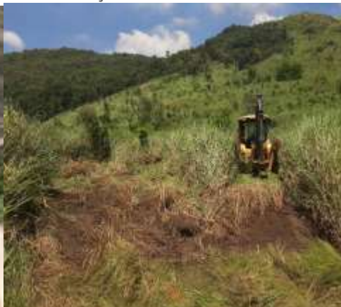
FIGURA 12 Roçada com retroescavadeira
