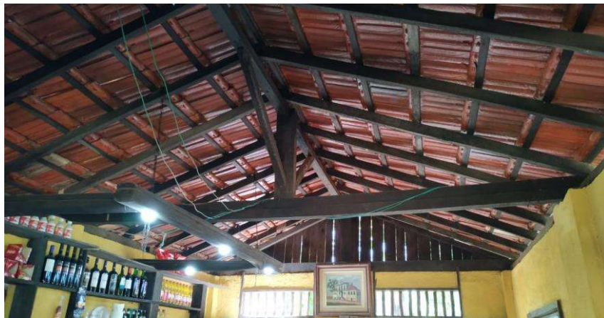
Figura 6 - Telhado Reconstruído e tratado. Fonte: O autor (2019)
