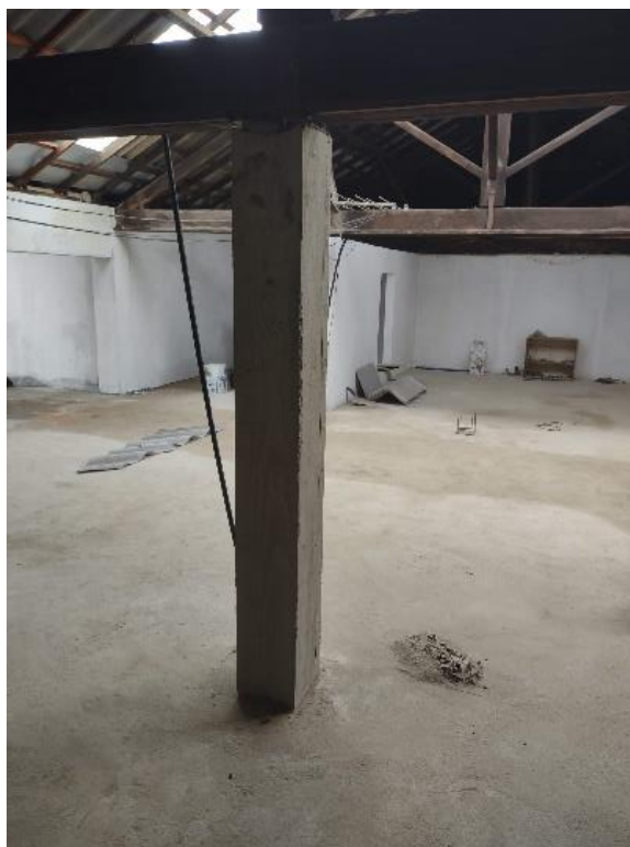
Figura 10: Pilar de suporte concluído. Fonte: Autor, 2022.
