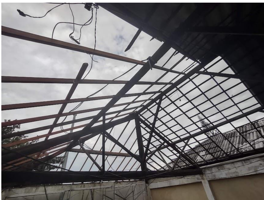
Figura 5 - Estrutura do telhado após o destelhamento Fonte: Autor, 2022.
