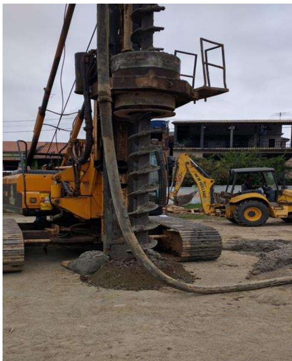
Figura 7 – Cravação da estaca hélice contínua. Fonte: Construtora IPR, 2018.
