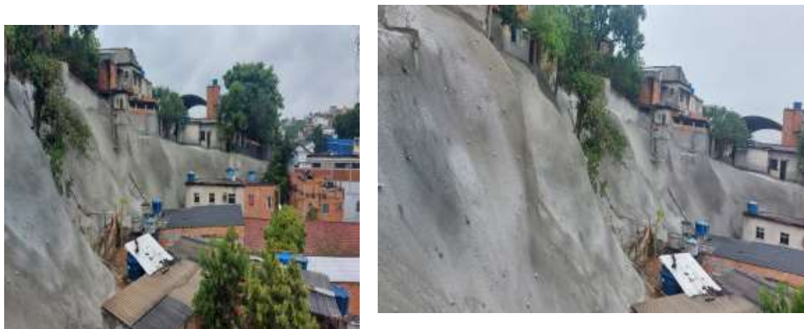
Figura 6. Finalização da contenção da encosta com o concreto projetado.
