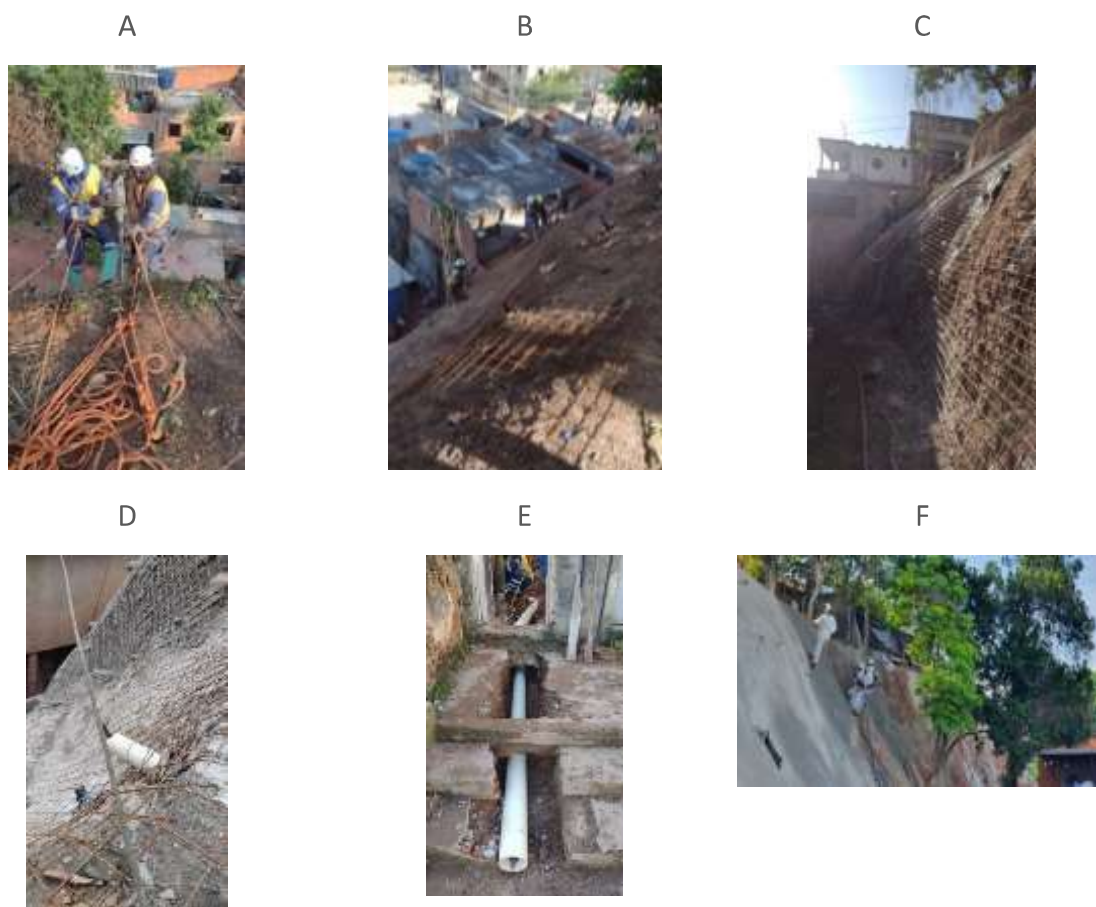
Figura 5: Etapas da contenção de encosta: a. perfuração do solo; b. instalação das telas eletrossoldadas; c. injeção dos grampos nos furos do talude; d. dreno barbacãs; e. sistema de drenagem com tubos 100mm e f. início do concreto projetado.
