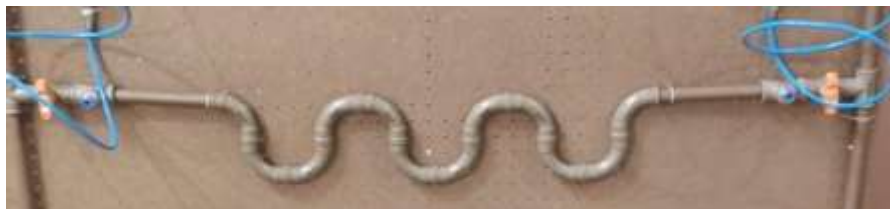
Figura 8 – Tubulação com 12 conexões do tipo curva 90°.
