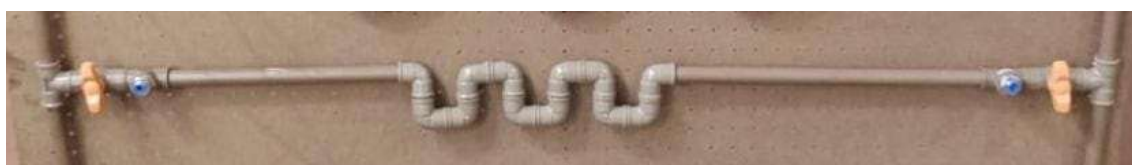
Figura 9 – Tubulação com 12 conexões do tipo joelho de 90°.
