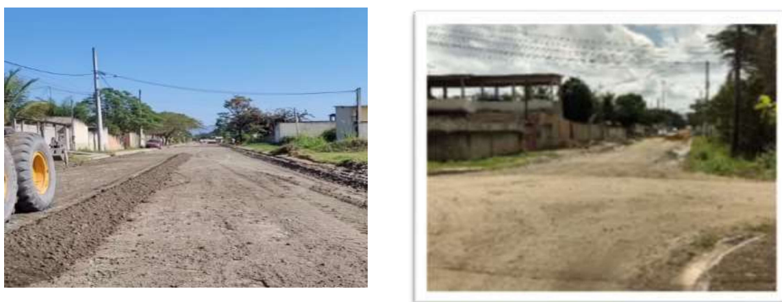
Figura 3: Etapas preliminares como, desbastamento, escarificação dos desníveis, retirada de pedregulhos e materiais diversos. Nas setas os meios fio concluídos no ano de 2014.
