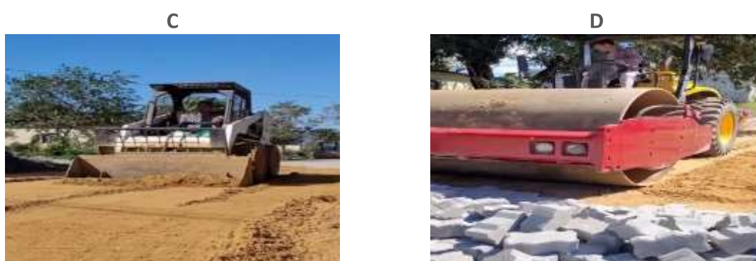
Figura 5: Minicarregadeira, espalhando o pó de pedra e o rolo compactador corrigindo defeitos na base.
