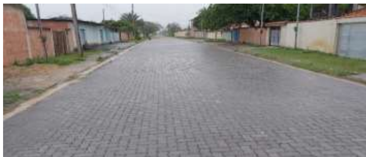
Figura 8: Orientação de espaçamento e rejunte entre as peças, demonstrando uma boa drenagem pluvial.
