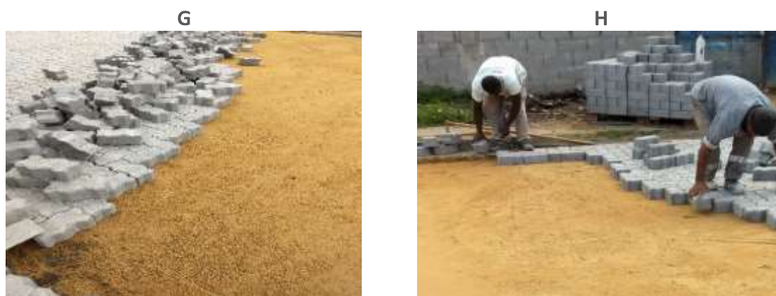
Figura 6: Posicionamento e assentamento dos artefatos manualmente.
