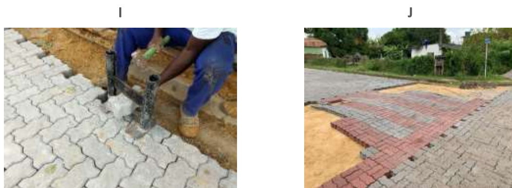
Figura 7: Peça é cortada de acordo com a medida do acabamento, sendo utilizado uma ferramenta de corte, figura I. Foi implantado quebra-molas entre as interseções, figura J.
