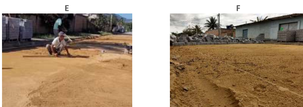
Figura 6: Nivelamento adequado e Alinhamento longitudinal e transversal das peças.
