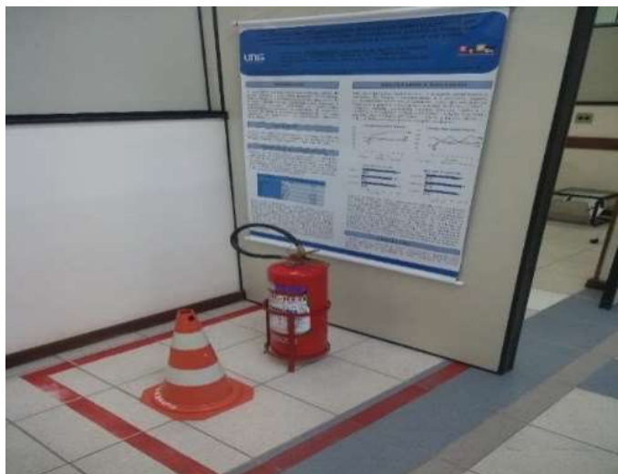
Figura 12 Extintor Fonte: Autora (2018).
