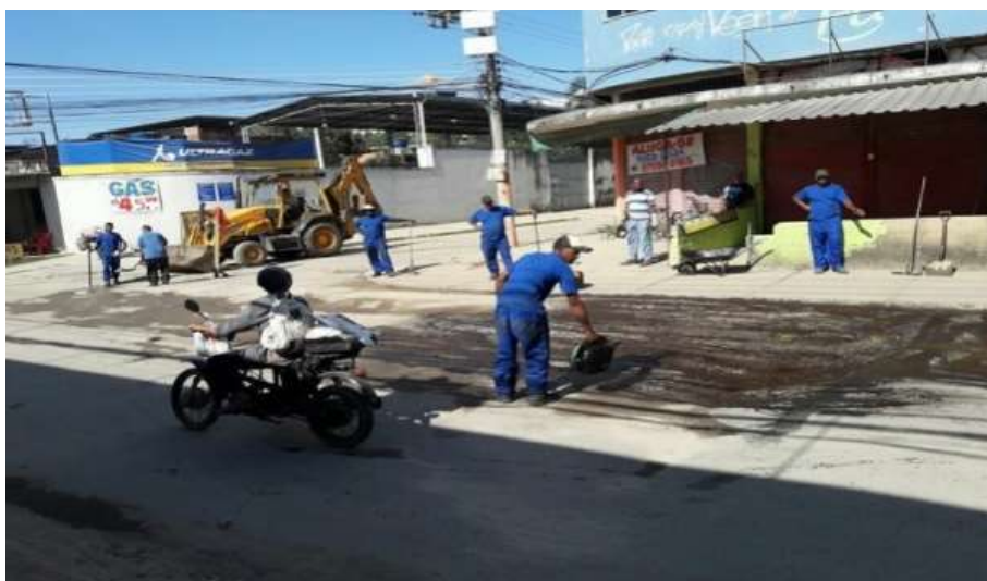
Figura 10: colocação da emulsão sob a cratera Fonte: (Autor, 2018)
