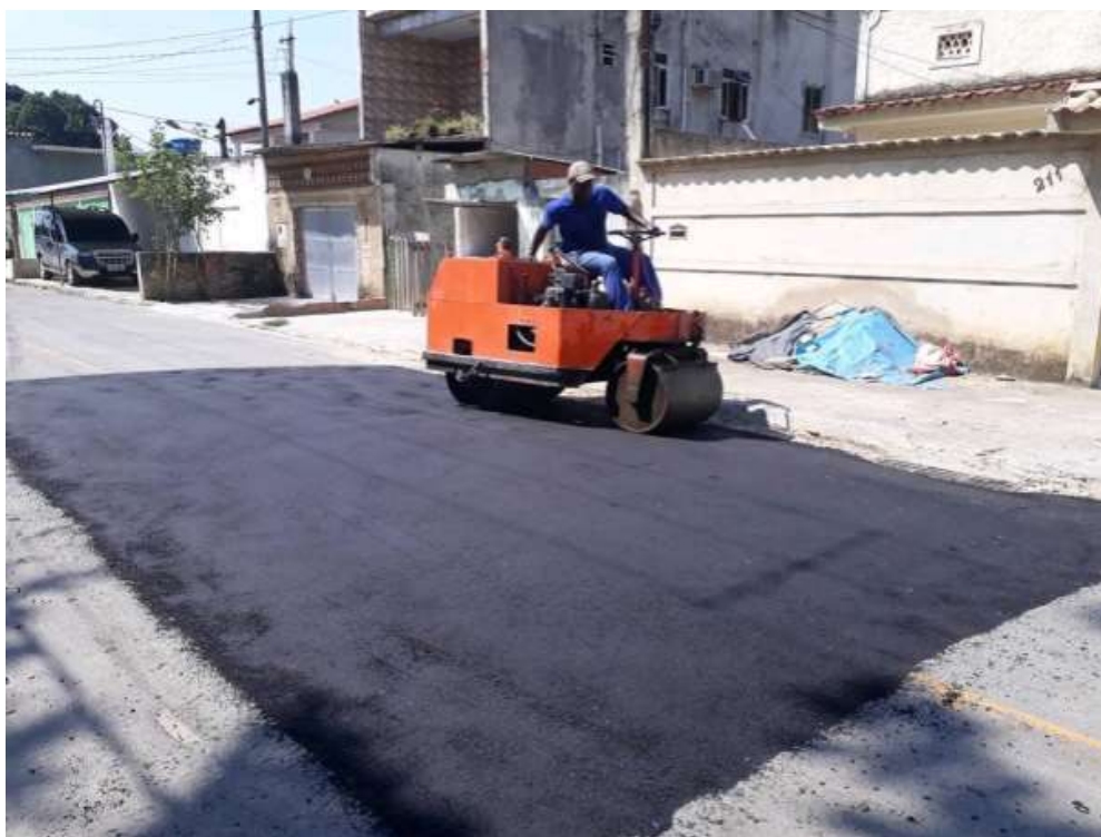
Figura 13: operador do rolo compactador Fonte: (Autor, 2018)
