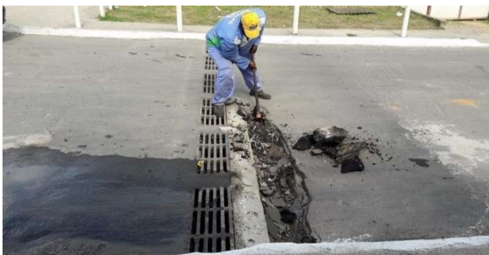
Figura 9: processo preparatório de limpeza para colocação da emulsão Fonte: (Autor, 2018)
