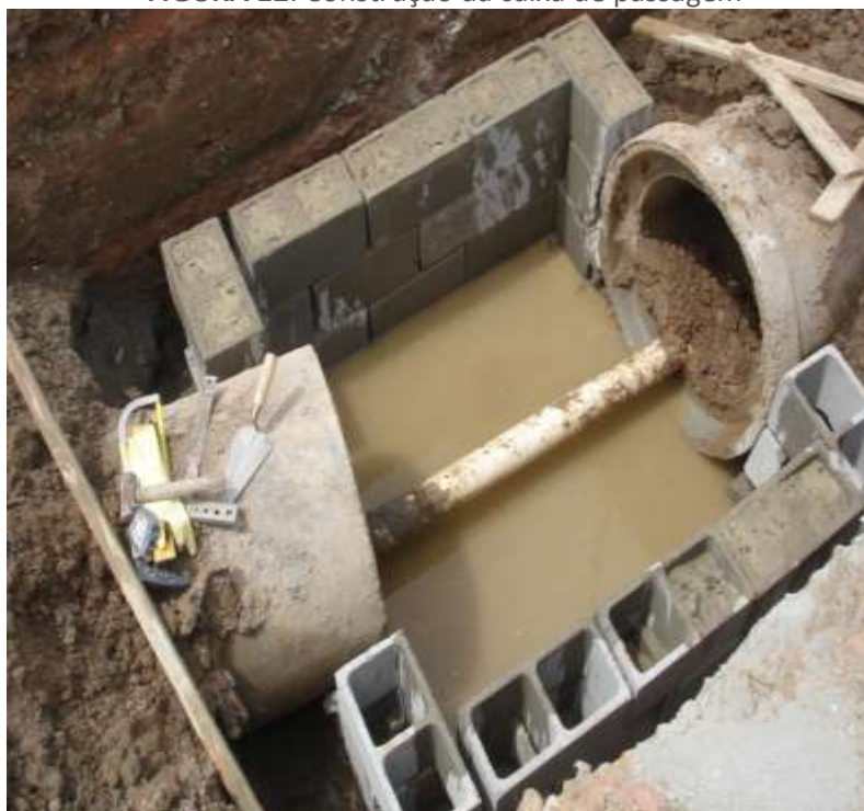
FIGURA 12: Construção da caixa de passagem
