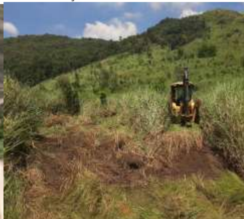
FIGURA 12 Roçada com retroescavadeira
