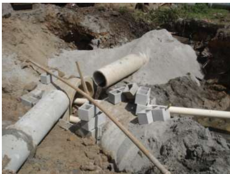
FIGURA 11: Trecho onde será construído um poço de visita. (PV)
