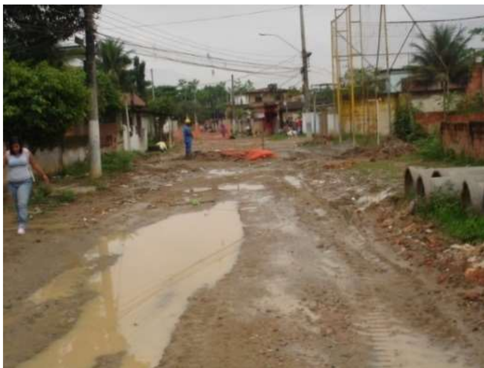
FIGURA 7: Rua Krakatoa antes do início das obras.
