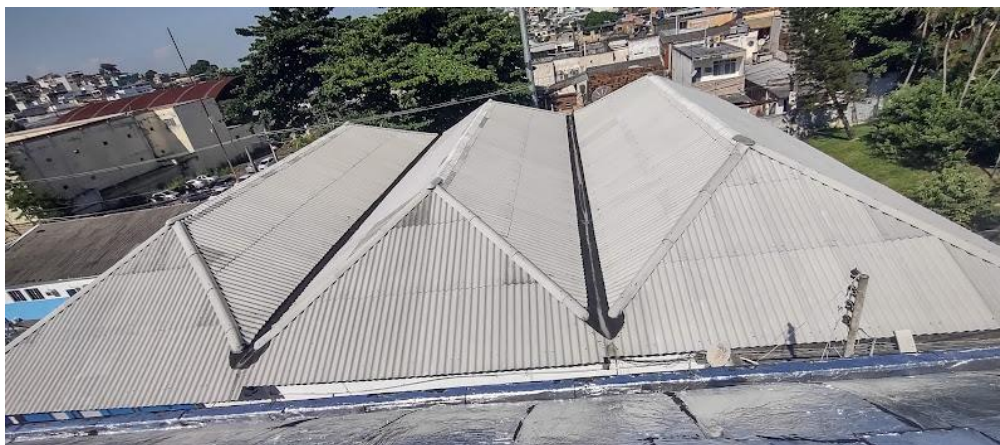
Figura 11: Telhado finalizado Fonte: Autor, 2022.
