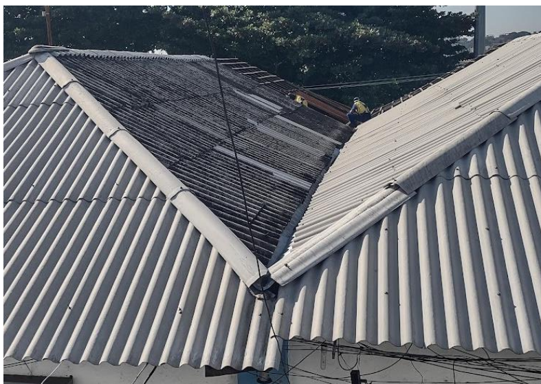
Figura 8 - Tamanho da calha antiga. Fonte: Autor, 2022.
