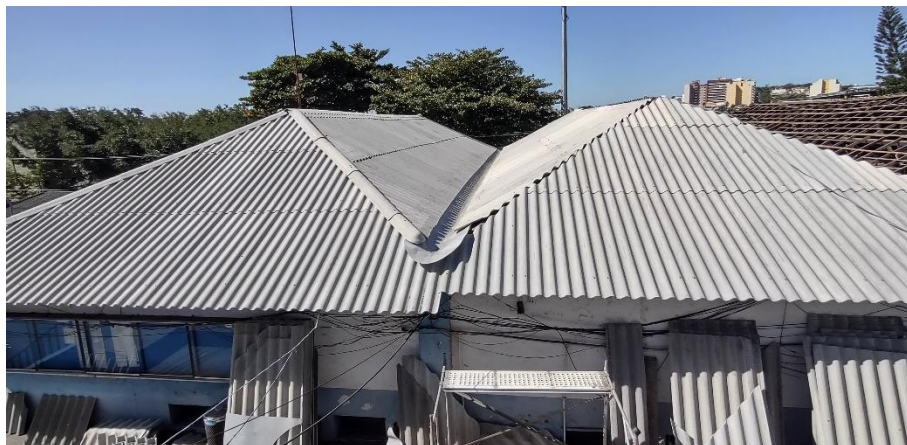
Figura 9 - Posicionamento da nova calha. Fonte: Autor, 2022.
