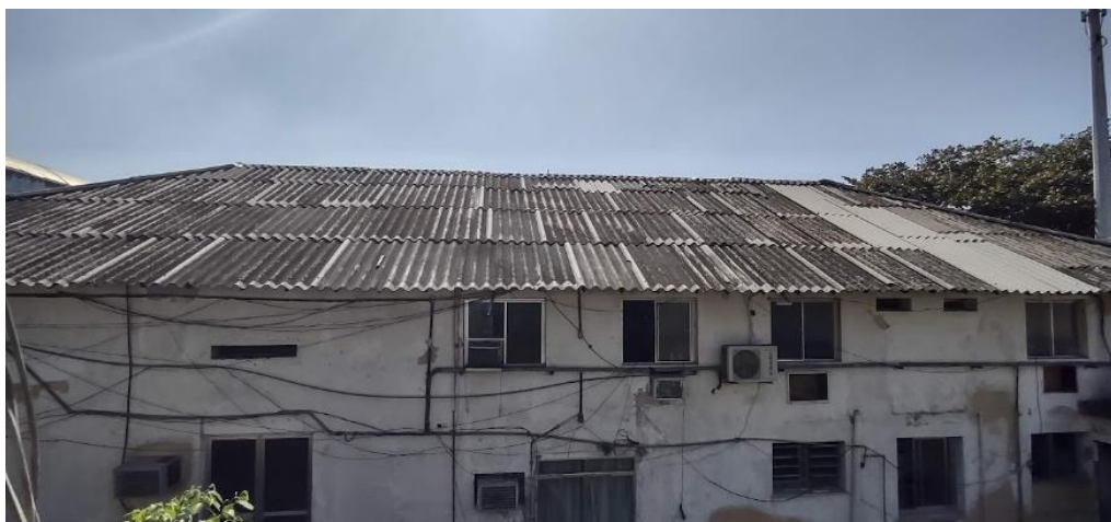
FIGURA 4 - Telhado antes da reforma Fonte: Autor, 2022.
